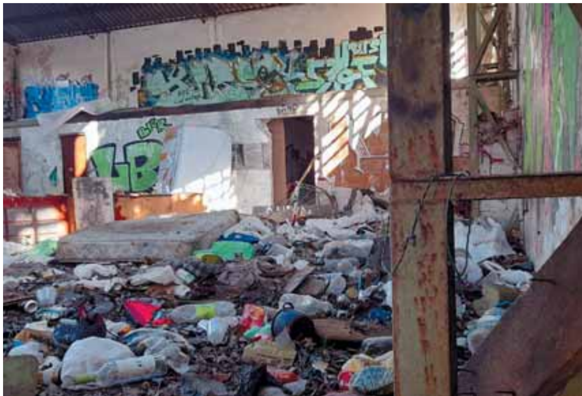
Aspecto que presenta el interior de la nave que acogió a la última fundición de Pamplona.
